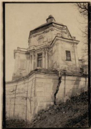
3. Церковный навесок большого Дорча.
