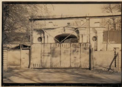
4. Западная проходная АИИ морских теплотехники. (Кухонный фронт)
